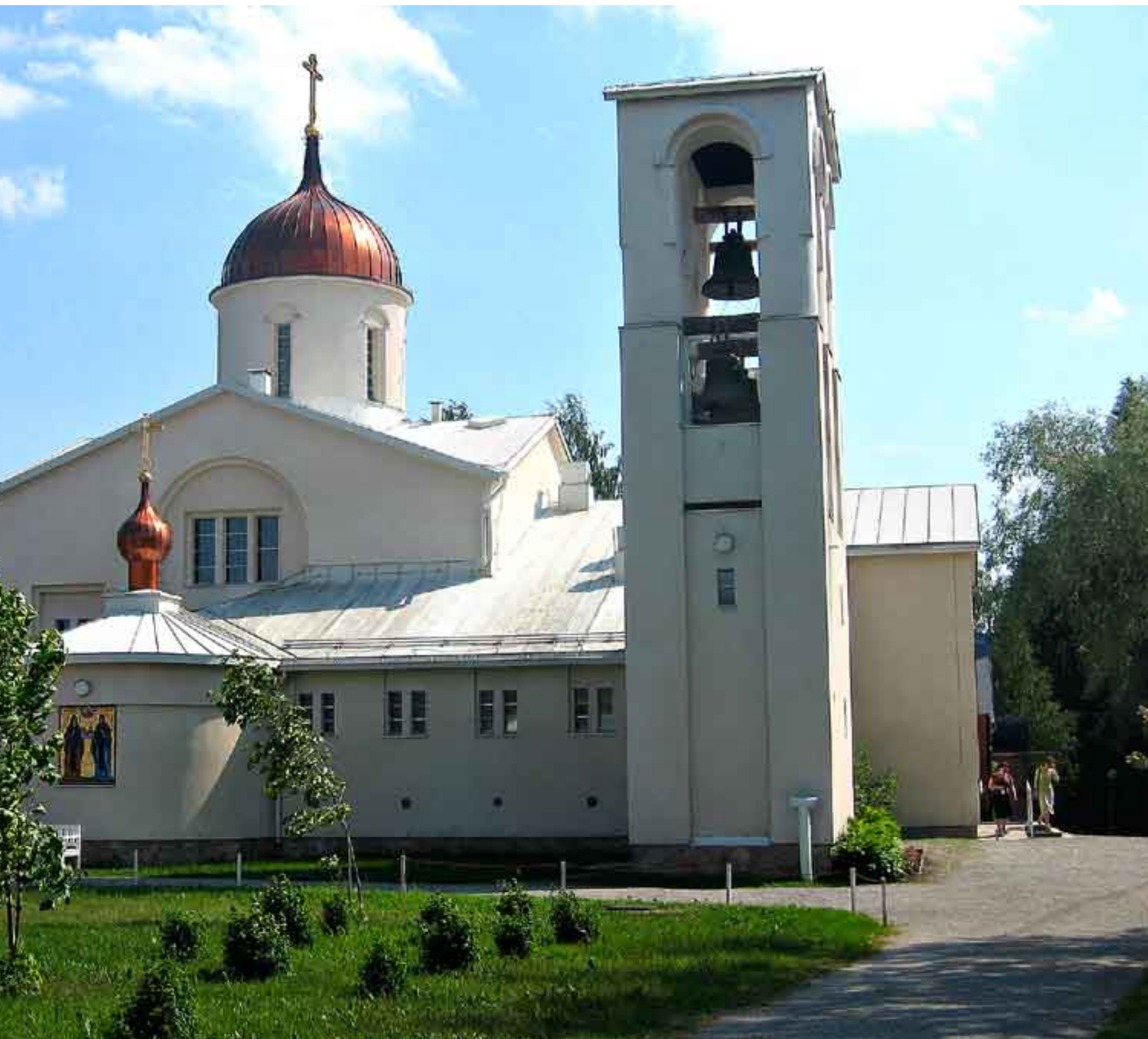
munkarna där dagligen utför är det centrum kring vilket klosterlivet kretsar.
