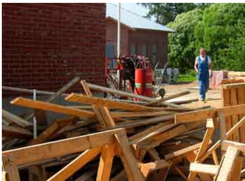
De senaste åren har byggnadsarbetena på nya Valamo avlöst varandra.
